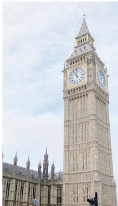
改修工事を終え、約5年ぶりに鐘の音が鳴るビッグベンの様子(13日、ロンドン)
