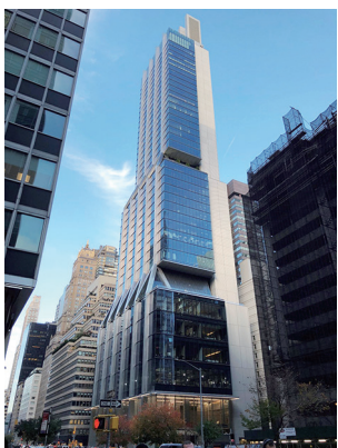
「425パーク・アベニュー」の外観(提供写真)
